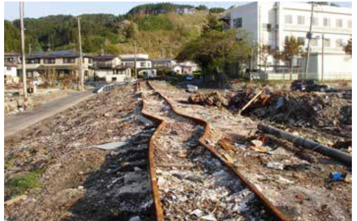
震災2ヶ月後 JR 山田線の線路と強固なはずの堤防も流されていた
