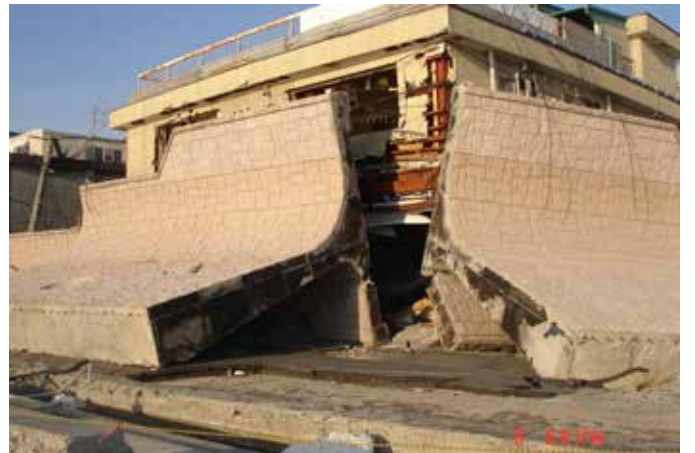
震災2ヶ月後 JR 山田線の線路と強固なはずの堤防も流されていた
